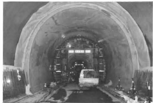
建設中のトンネル内の様子(先端部分)KRMCご提供
