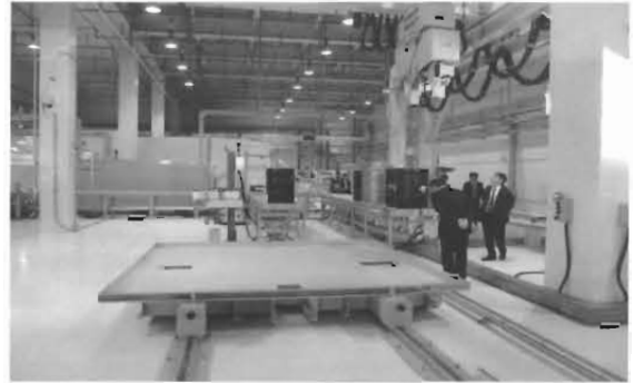
受入検査・貯蔵施設
