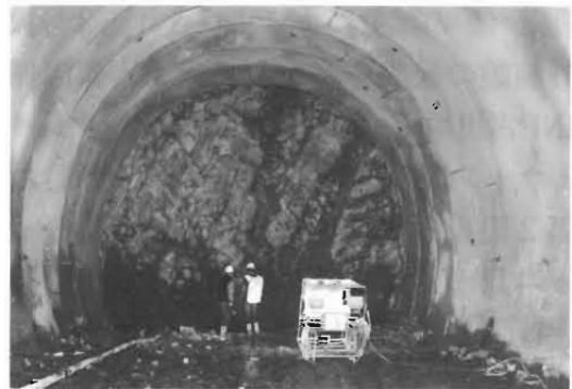
建設中のトンネル内の様子。KRMCご提供
