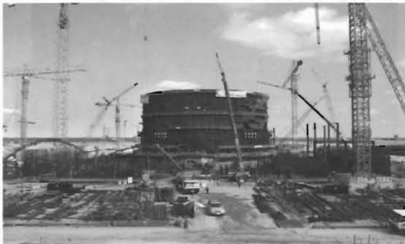
建設中の新古里発電所。KHNPご提供資料より
